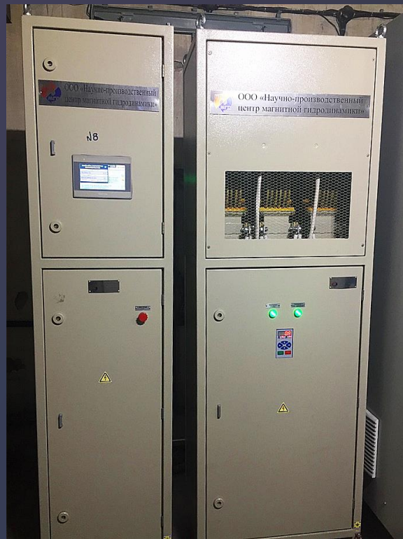
источник питания с компенсацией реактивной мощности (для 2 и 3-фазных типов)
