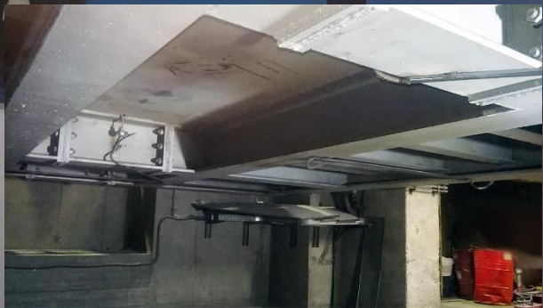
Варианты исполнения немагнитной плиты: «нержавеющий лист» и «усиленное гнездо»
