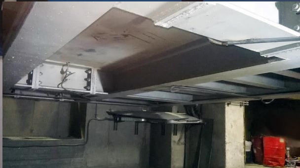
Варианты исполнения немагнитной плиты: «нержавеющий лист» и «усиленное гнездо»
